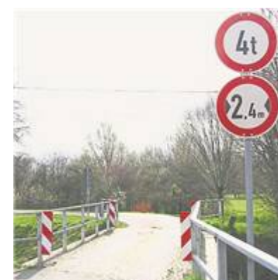
Trotz Gewichtsbeschränkungen wurde die Brücke auch von schweren Traktoren befahren. ARCHIVFOTO: SP
